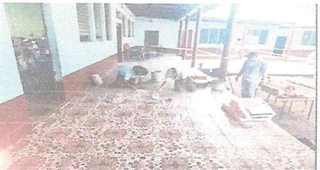
Foto 4: Se muestra la colocación del piso cerámico.
